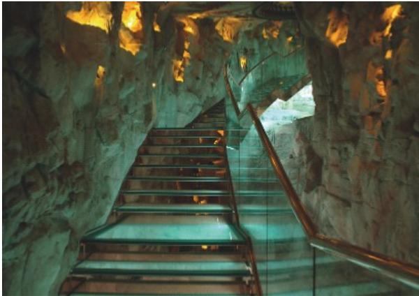
Diese exklusive Glas-Stiege wurde mit CAD & Proliner vermessen. **100 Stufen-Unikate** liegen auf einer Stahl-Unterkonstruktion, die mit **titan-bedampften Edelstahlblechen** vergoldet wurde.
